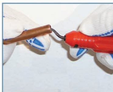
تصویر ۲: زدودن پلیسه‌های داخلی
