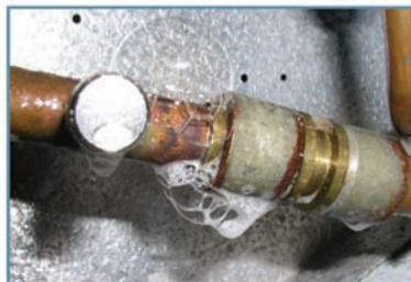
تصویر ۱۸: حباب نشان‌دهنده نشتی
