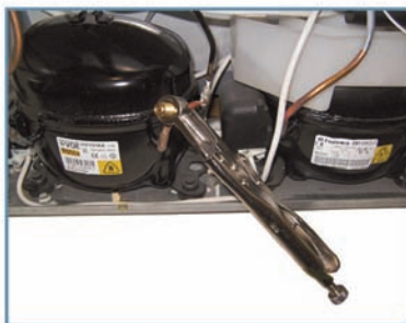
تصویر ۱۳: وصل کردن نیتروژن به لوله سرویس
