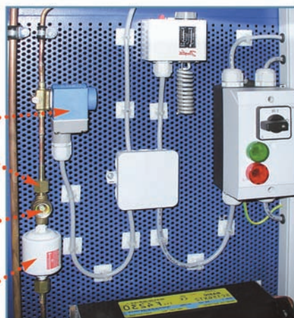
تصویر ۱۸: اجزای مدار (چرخه) تبرید
